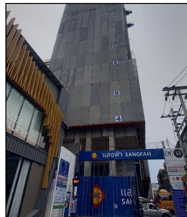
ภาพที่ 1 รั้ว Metal Sheet ความสูง 6 เมตร ต่อด้วย Mesh Sheet ความสูง 2 เมตร รอบพื้นที่โครงการ
