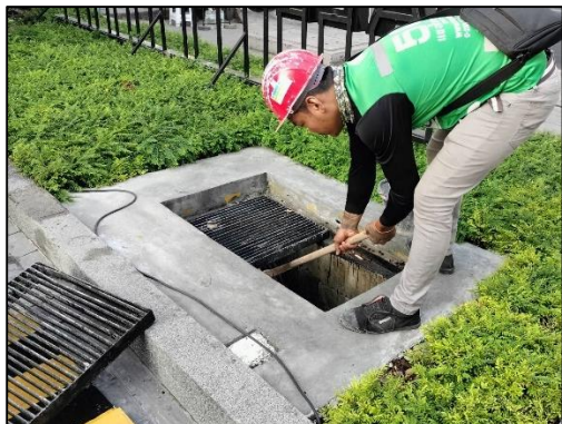
ภาพที่ 20 กิจกรรมขุดลอกท่อระบายน้ำสาธารณะด้านหน้าโครงการ
