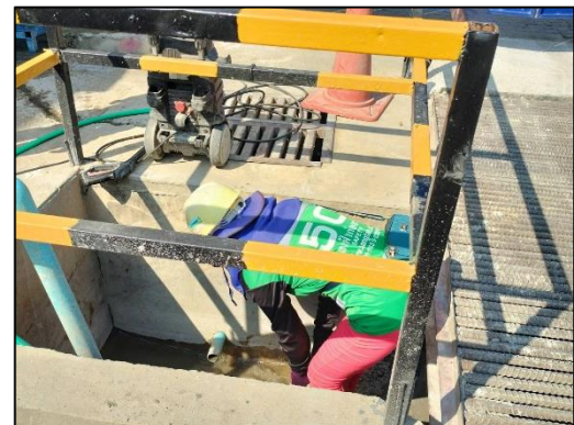
ภาพที่ 36 กิจกรรมขุดลอกที่ระบายน้ำในพื้นที่โครงการ
